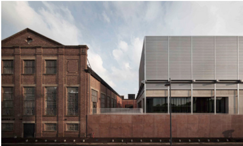
Fig. 26. C-mine , 51n4e, 2010, Genk (51n4e, 2010)
